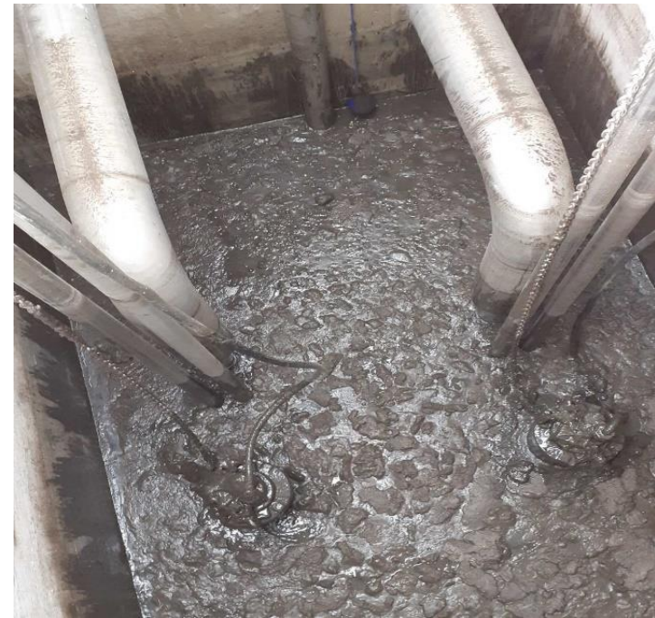
Slika: CS sa novim muljnim pumpama za reciklaciju mulja
