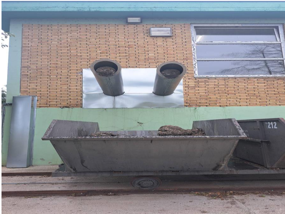
Slika: Prese sa kontejnerima kod finih rešetki
