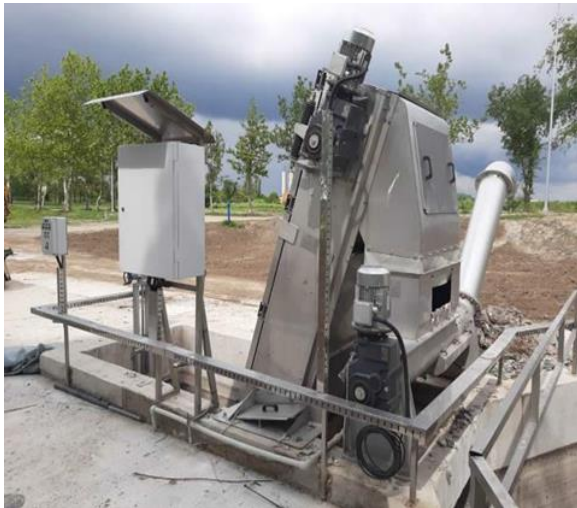
Slika: Gruba rešetka sa presom
